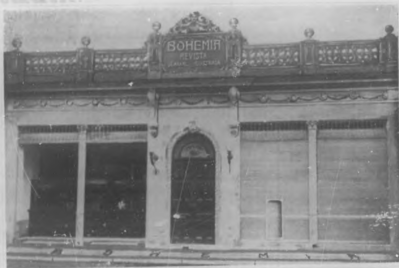
Edificio de "Bohemia" situado en Trocadero 89, 91 y 93 donde se encuentran instaladas sus oficinas y talleres.
